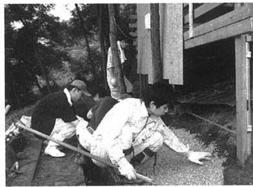
「建設の日」の作業風景。この日は、山羊小屋の下にコンクリートを流し込み、衛生面を整える作業などを行った。
